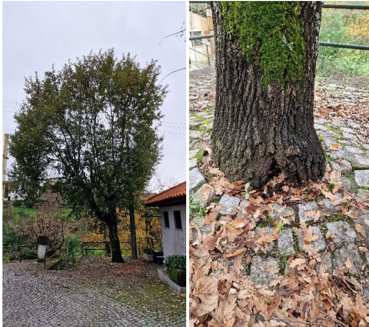
Figura 16 – Aspeto geral da árvore nº 11 (esq.) e pormenor de uma cavidade no colo (dir).
